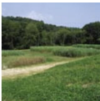
↑ Rastlinska čistilna naprava s polno vzpostavljeno vegetacijo Constructed wetland with fully established vegetation
